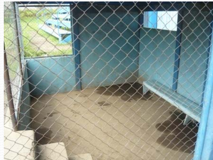
INTERIOR DE DOGOUT ANTES DE REHABILITACION
